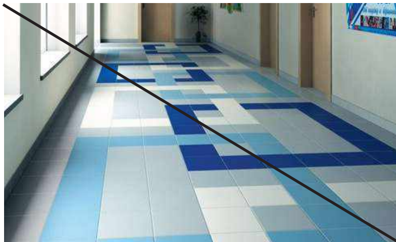
Плохо Цветные вставки из плитки
